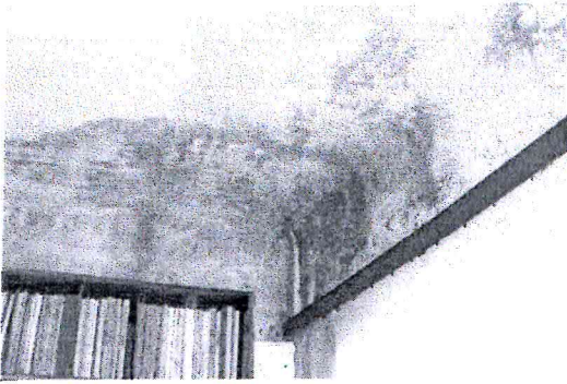
1.att.Jumta segums ir bojāts kā rezultātā tiek bojātas jumta un pārseguma konstrukcijas
