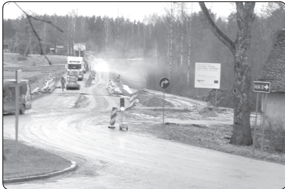
Tilta pār Ķires upi Kārķos rekonstrukcija, kuru veica SIA «Rīgas tilti»
