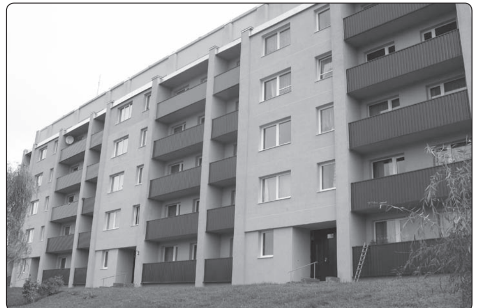
Daudzdzīvokļu māja Ausekļa ielā 46, kura siltināta projekta ietvaros
