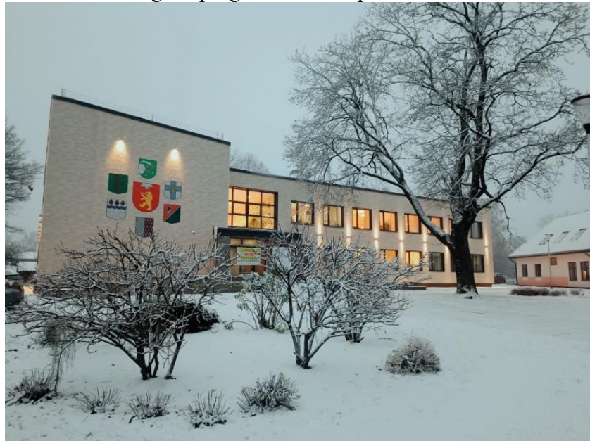
15.att. Energoefektīvā ēka Beverīnas ielā 3, Valkā
